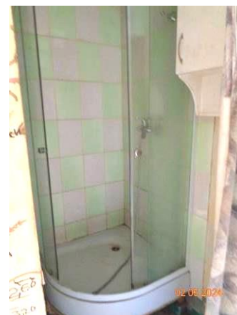
Dzīvokļa Nr. 8 telpas Ēkas 2.stāvā
